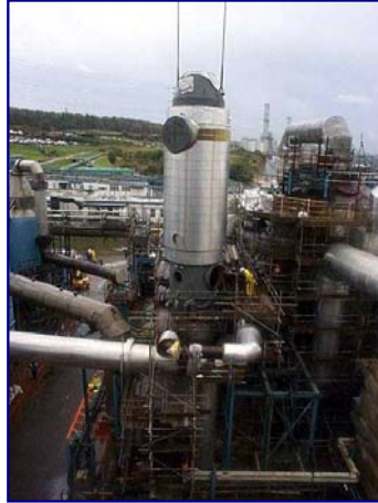
Trocador gás / gás sendo instalado na Ineos, Runcorn UK.
