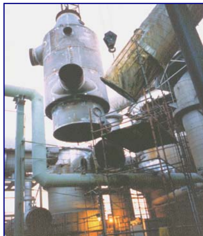
Reforma de um trocador gás / gás na IMC-Agrico Florida
